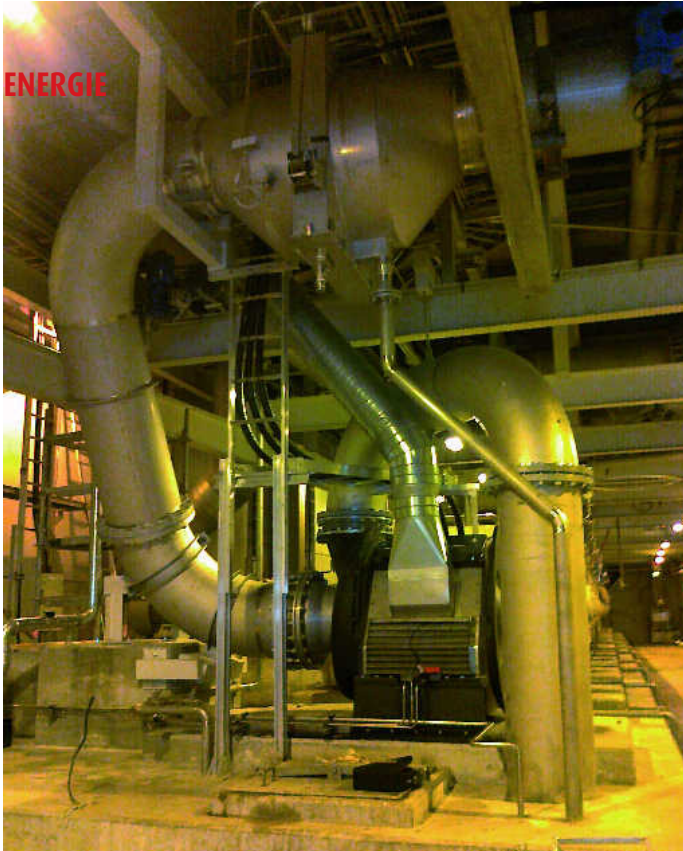
Abb. 5: Ecopump Turbo 1 mit zusätzlichen Tropfenabscheider EcoSep™ (Stora Enso Sachsen)
