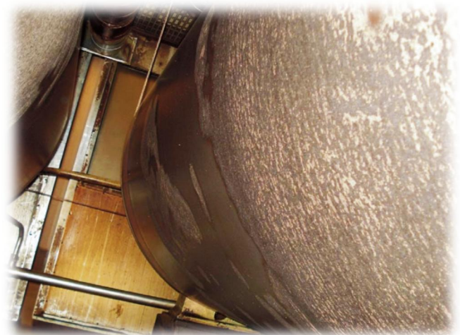
Zuvor: Stark verschmutzte Zylinderoberfläche
